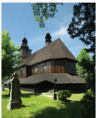
Dřevěný kostel Všech svatých v Sedlištích
