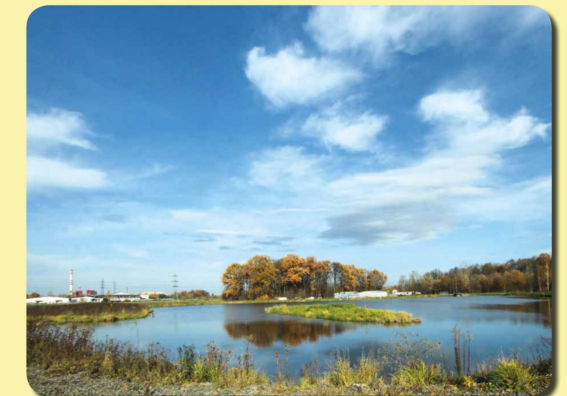
Nová retenční nádrž z r. 2011. v pozadí průmyslová zóna
