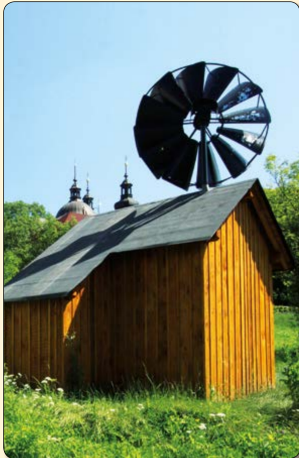
Nově zrekonstruovaný mlýnek v Šenově
