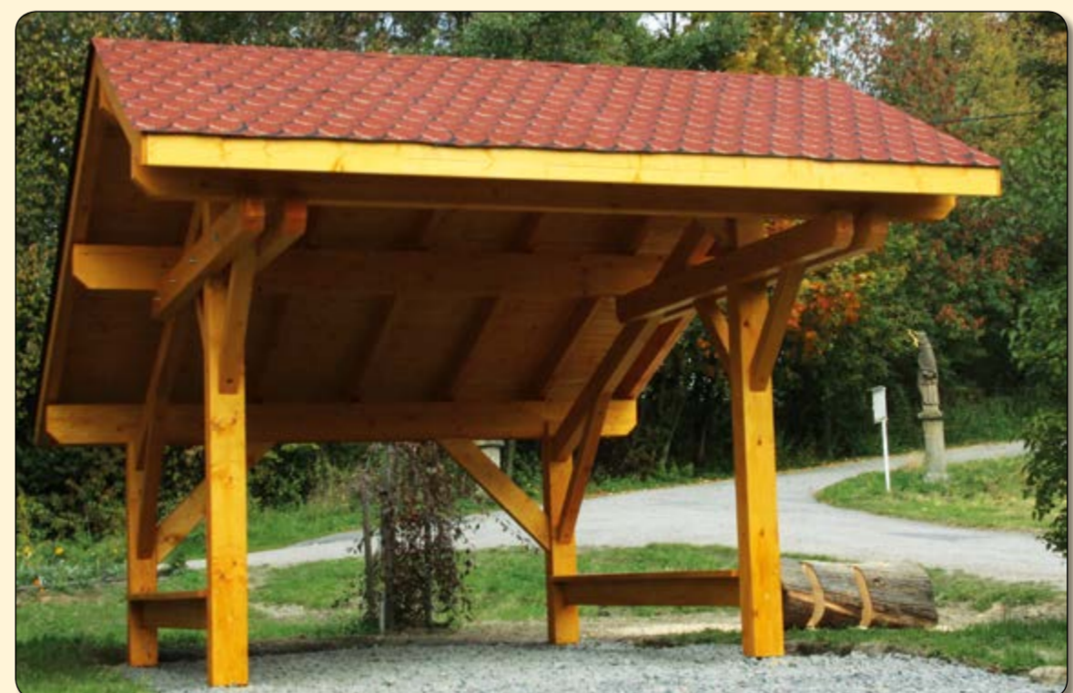
Krytý přístřešek pro návštěvníky u mlýnku v Šenově
