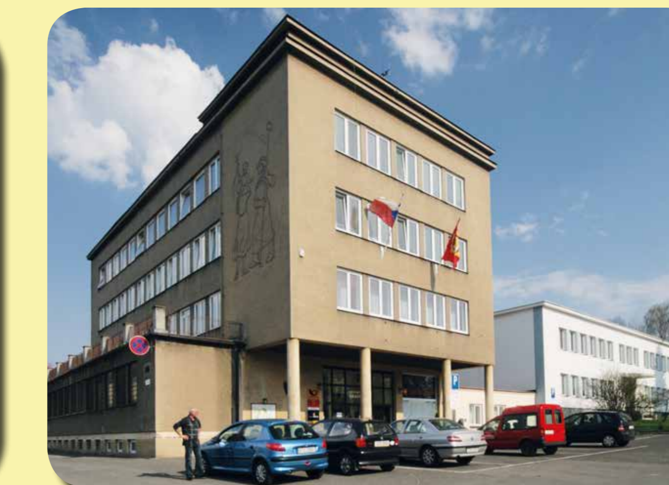
Budova městského úřadu
