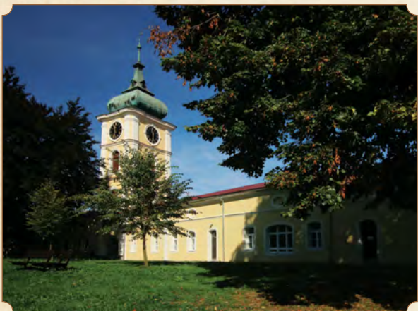
Pohled na budovu předzámčí ze zámeckého parku
